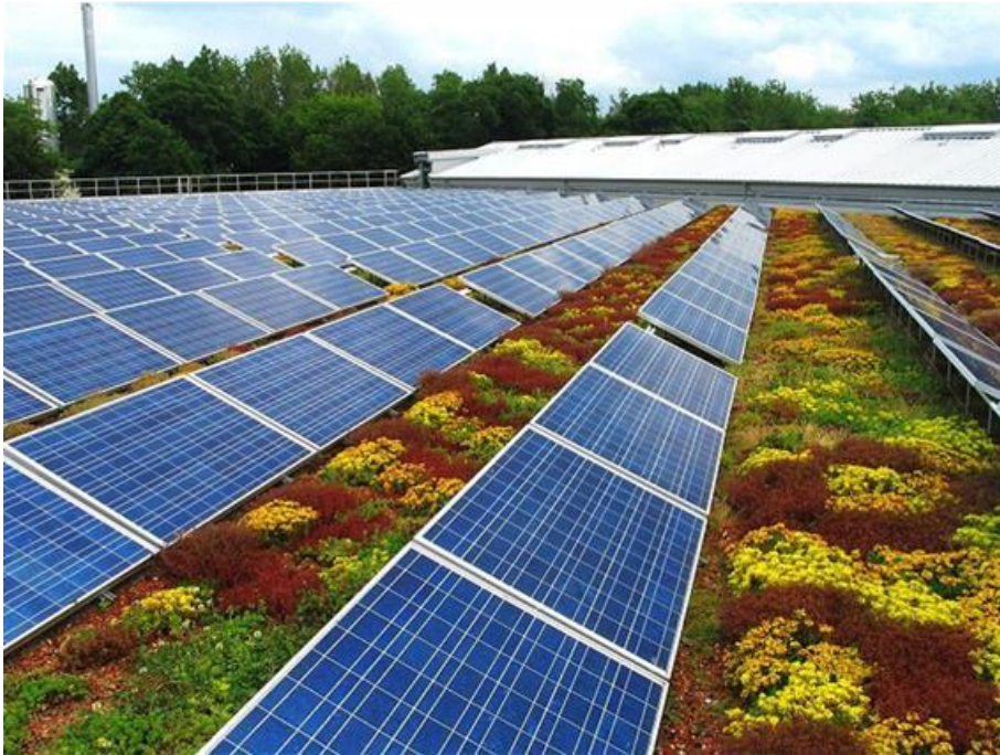
Abbildung 11: Gutes Beispiel einer Dachbegrünung mit Photovoltaikelementen in Dresden. (MVI 2012)
