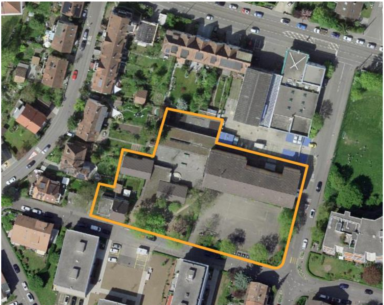
Abbildung 21: Liegenschaft 956 mit Schule, Kindergarten sowie Wohnhaus. Quelle: GeoView.bl
